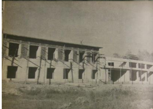
Hotel de Turismo de Isla del Diamante, San Rafael Hotel de Turismo de Tupungato, en construcción. Hotel de Turismo de Tunuyán, en construcción. Fuente: Gobierno de Mendoza. Agua, vivienda y salud. Tres años de labor justicialista , Mendoza, Secretaría de Comunicaciones, 1953.
